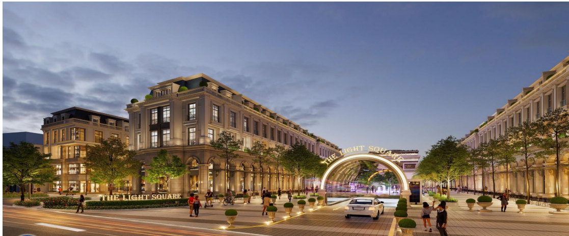
Hình 13: Dự án nhà ở Thương mại The Light Square
